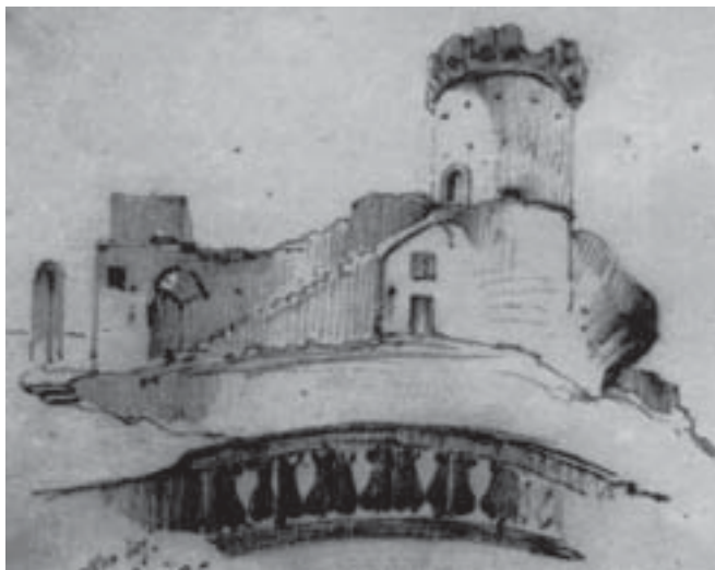
2. Pasquale Mattej (2 agosto 1847): il Torrione visto dal palazzetto d'Ascìa non mostra nessuna delle grandi aperture che il Maltese vi aprirà tra la fine del sec. XIX e l'inizio del successivo.
