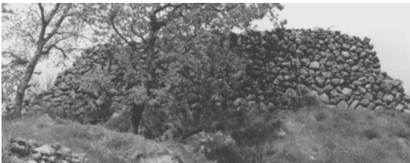
Parracina di riparo dal vento
